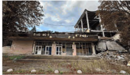
Una fabbrica di strumentazione ottica a Izjum: distrutta
