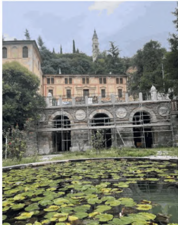
La facciata in corso il restauro dei medaglioni FOTO ANNA ROSSI
